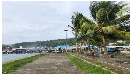
Gambar 2. Kondisi RTH Taman Jokowi
